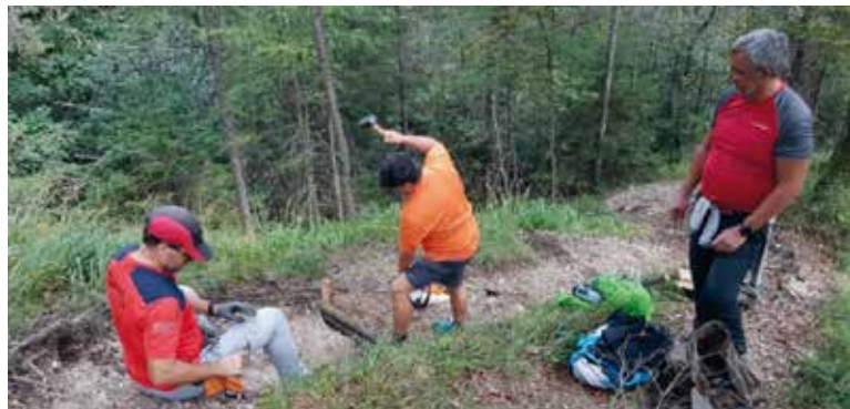
Einbau neuer Stufen am Dötzenkopfweg
