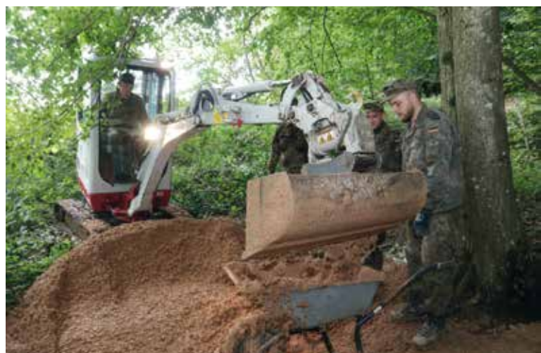
Die Gebirgspioniere der 4. Kompanie aus Ingolstadt beim Bau des Umgehungsweges.
