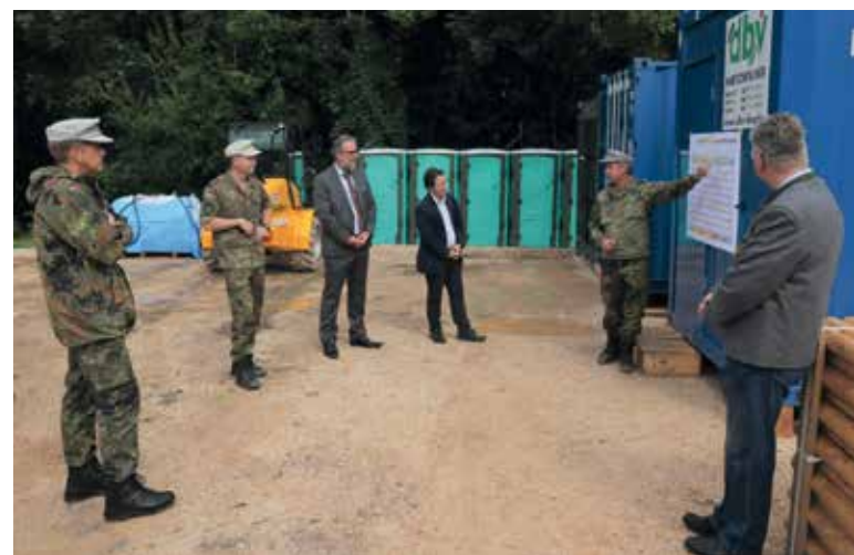
Oberstleutnant Georg Pyttlik bei der fachlichen Einweisung in den Wegebau.
