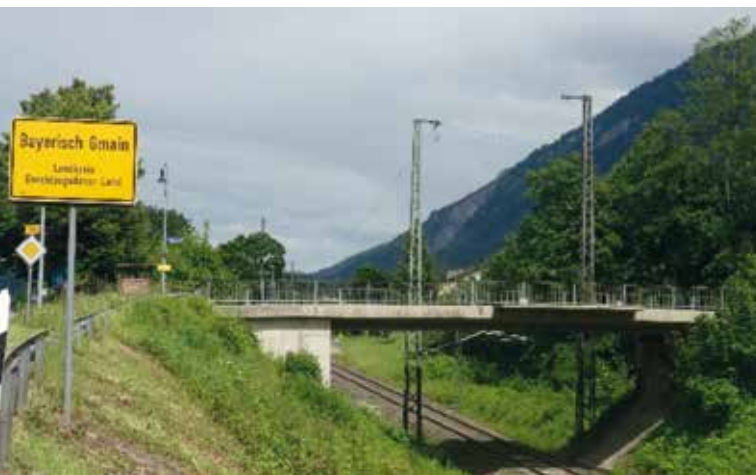
Kendlinger Brücke, Foto: Franz Sicklinger
